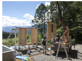
離れは東京で仮組みしユニット施工。3日間で完成
