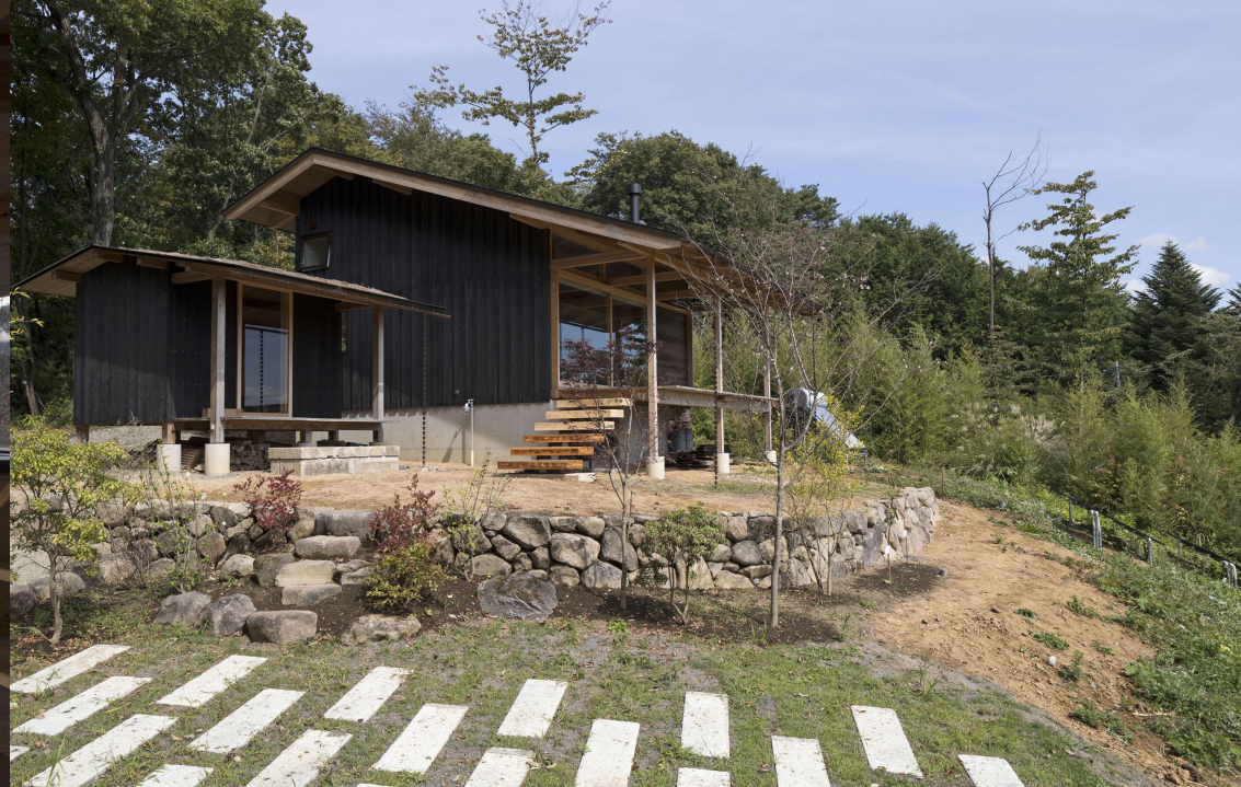
厚さ20mmの焼スギ板外壁とスギCLTを使った2方向跳ね出し階段。屋外暴露試験中
