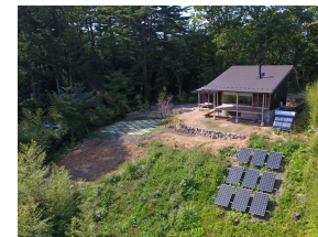
防災拠点となるよう電気・ガス・水道を自給自足
