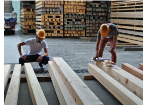
施工者と設計者が製材所で柱・梁に番付をふる
